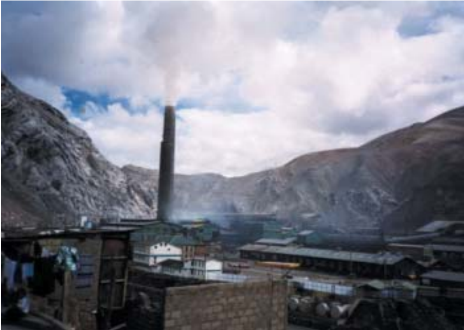
Metallurgischer Komplex La Oroya
